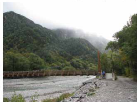
雨上がりの明神橋を右岸北側より
